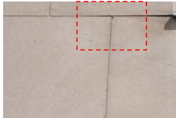
Petit éclat dans le joint – E8 ; a et b
