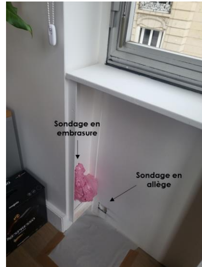
Photographies des deux sondages réalisés par l'intérieur
