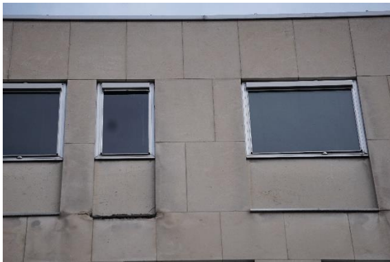
Vues lointaine et rapprochée d'une corniche manquante – E15 ; q
