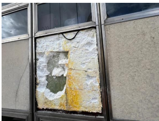
Sondage destructif réalisé par une équipe de cordistes – place du Panthéon
