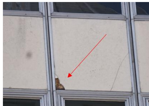
Eclat important en coin d'une pierre – E8 ; T9 Remarque : on aperçoit l'isolant derrière la pierre, celui-ci semble dégradé du fait de son contact avec l'extérieur
