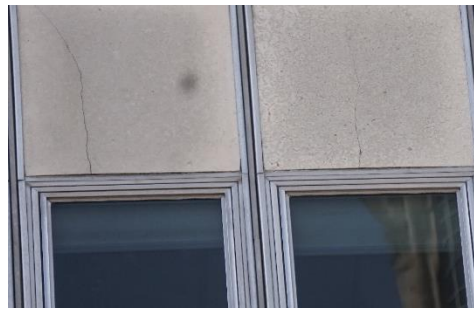
Pierres bombées vers l'extérieur en partie centrale – E6 ; T6 et T7
