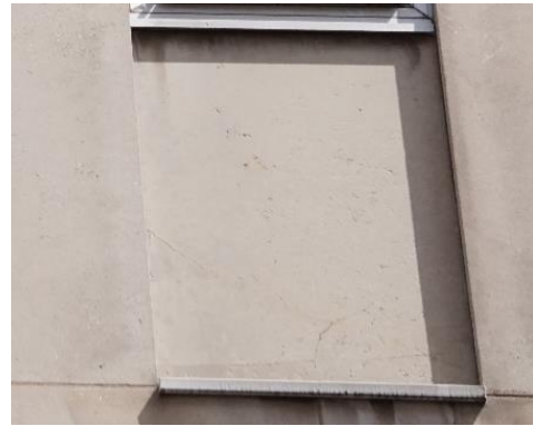
Pierre sous une baie fissurée – E9 ; n
