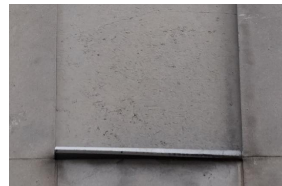
Vues lointaine et rapprochée d'une corniche altérée – E12 ; j
