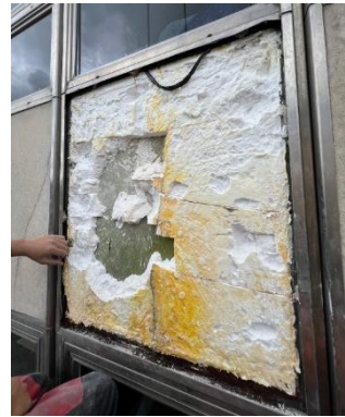
Photographie de l'isolant disposé entre l'arrière de la pierre et la tôle métallique
