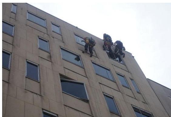
Relevé des pathologies et purge des petits éléments prêts à tomber – rue d'ULM
