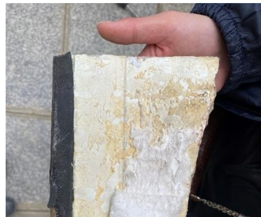
Photographie du joint noir disposé entre l'intérieur de la pierre et le rail
