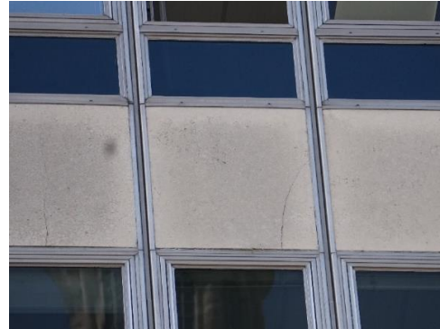
Fissure arrondie en coin de la pierre – E6 ; T8
