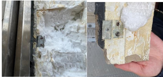
Photographies du système de fixation entre la pierre et le rail par l'intermédiaire d'un plat métallique et de rivets POP
