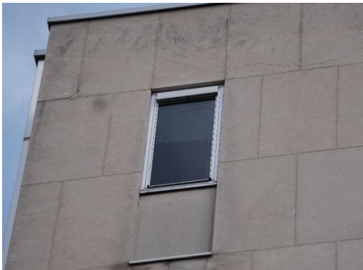
Encrassement en partie haute de la façade – E15 à E17 ; a à e
