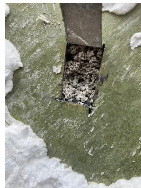
Photographies montrant la tôle métallique découpée et le remplissage en petits cailloux
