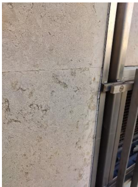
Absence de joint entre deux pierres verticales en travée 1
