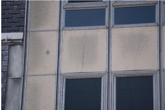
Fissure verticale trouvant son origine au point central bas de la pierre – E3 ; T2 et T3
