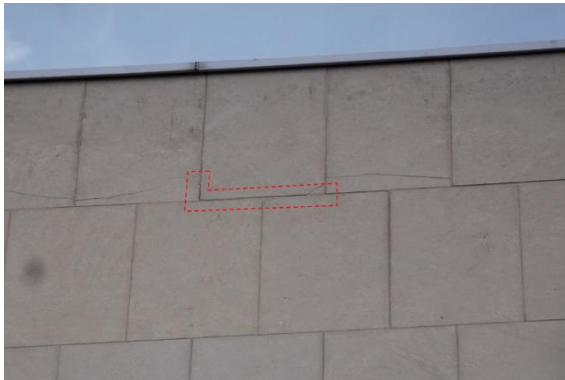
Joints dégradés à proximité d'une fissure – E17 ; d à h
