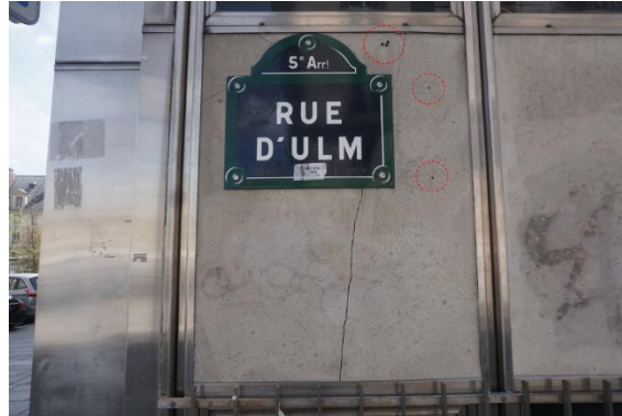
Percements à différents endroits de la pierre au rdc – E1 ; a
