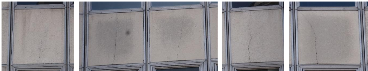
Photographies de pierres fissurées et bombées : désordres récurrents
