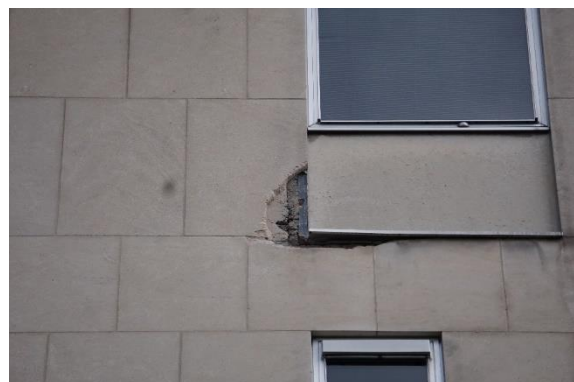
Eclat important purgé en-dessous d'une baie – E15 ; h
