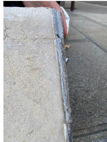
Photographie du joint gris disposé entre la surface de la pierre et le rail
