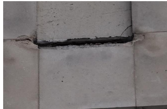
Vues lointaine et rapprochée d'une corniche manquante – E15 ; q
