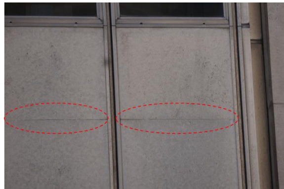
Absence de joint entre deux pierres de la rangée E2 ; travées 9 et 10
