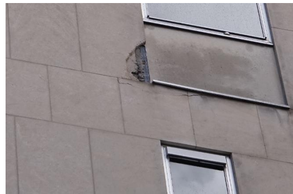
Taille de pierre plus petite observée au-dessus des baies
